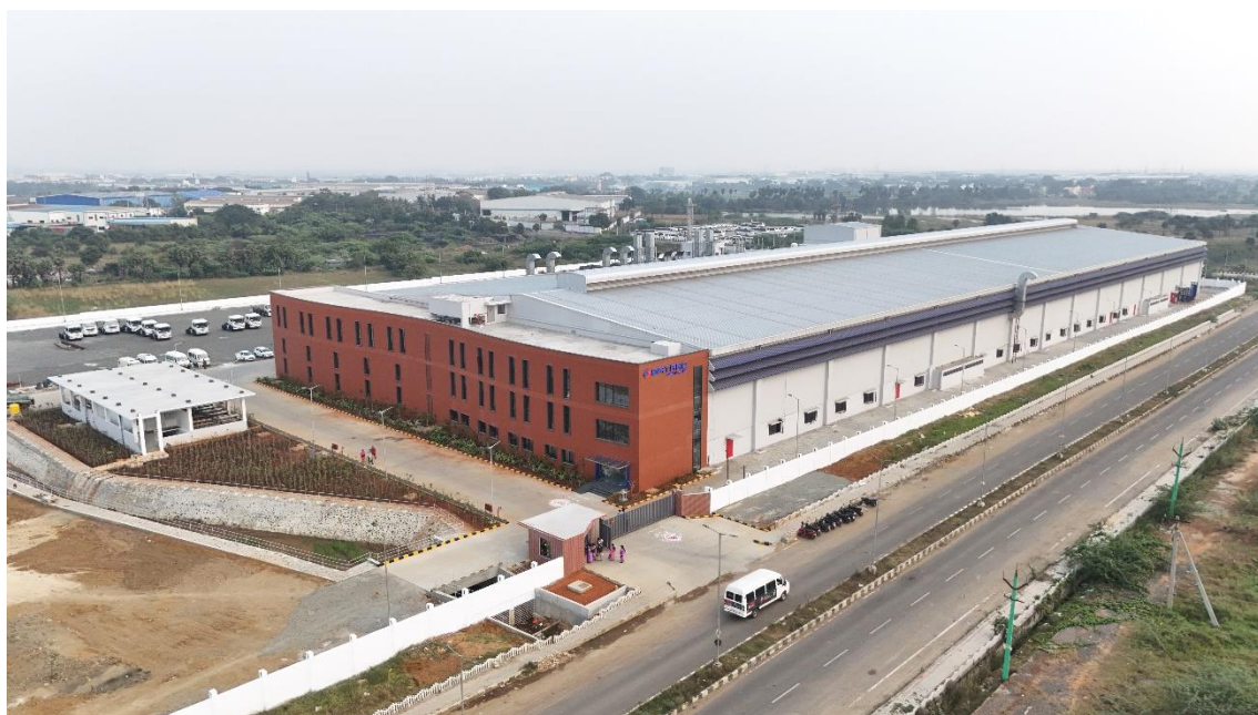
竣工したチェンナイ工場全景
