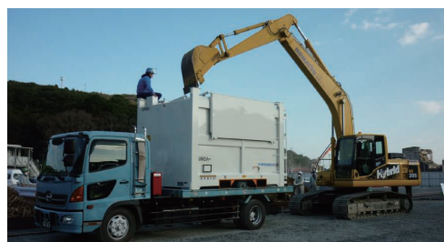
震災がれき輸送システムを活用した女川町での積込作業(2012年)
