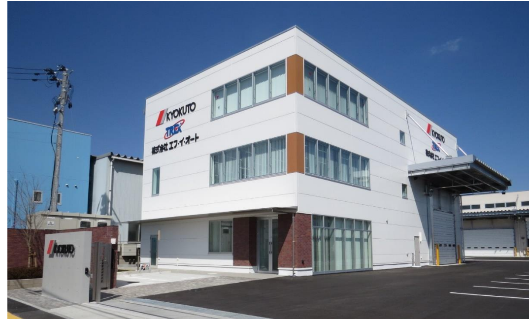
極東開発工業/ 日本トレックス 東北支店 エフ・イ・オート 仙台サービスセンター
