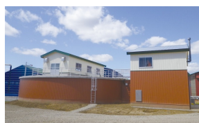
バイオガスプラント (パネル展示)
