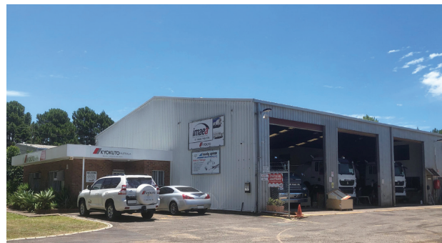
Kyokuto Australia Pty Ltd 本社・工場外観
