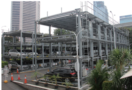
インドネシア 大規模立体駐車装置 (Wisma Indocement)
