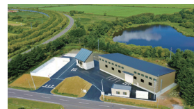
使用済み紙おむつ燃料化施設 (西天北サーマルリサイクルファクトリー)
