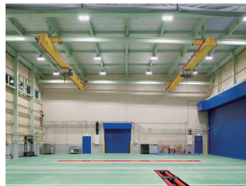
センター内 整備ブース
