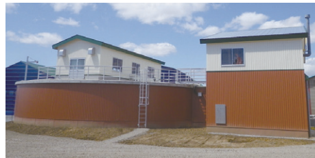
バイオガスプラント
