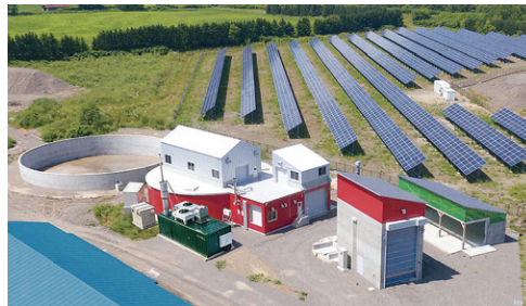
興部北興バイオガスプラント
