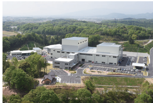
津市リサイクルセンター（三重県）
