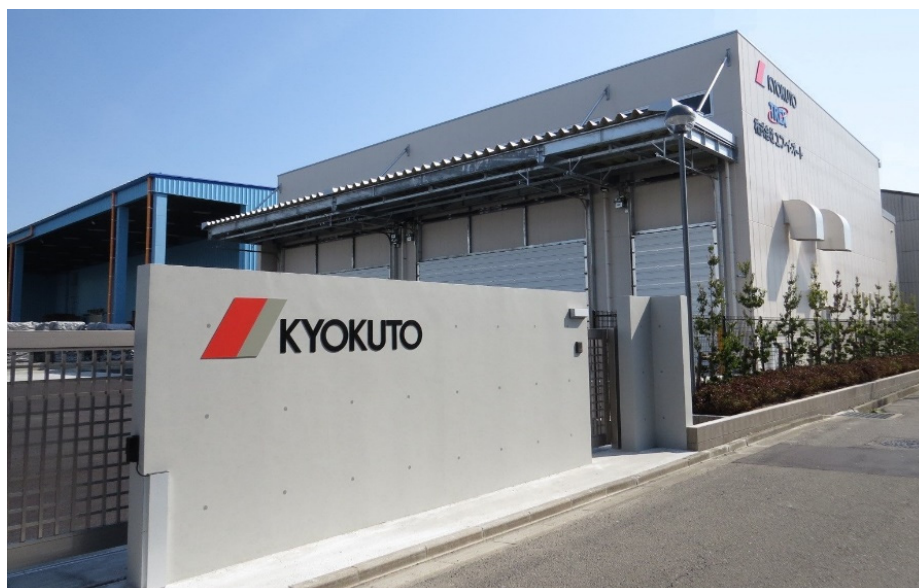
仙台サービスセンター 整備工場棟
