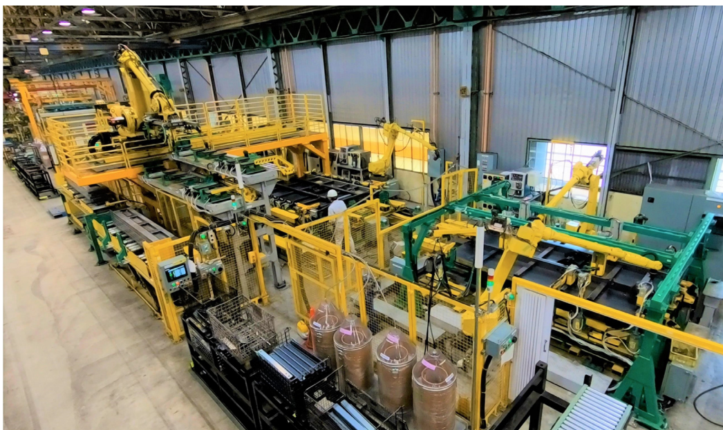
横浜工場 中型リヤダンプトラックボデー自動化ライン
