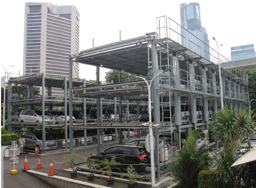
インドネシア 大規模立体駐車装置 (Wisma Indocement)
