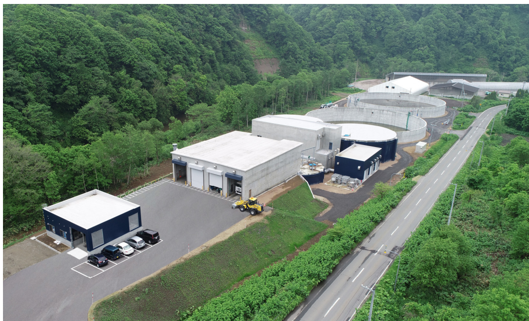
豊浦町バイオガスプラント
