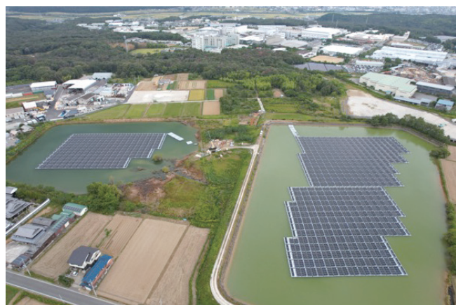
ため池ソーラー全景
