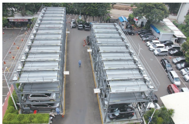
駐車装置配置状況
