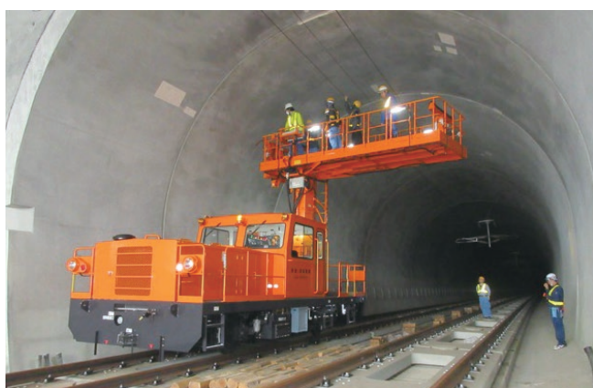
新幹線向け架線作業車
