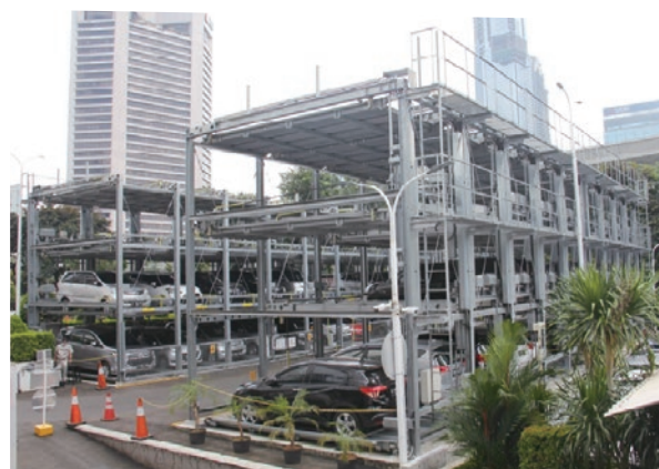
立体駐車装置
