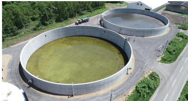
図9 消化液貯留槽
