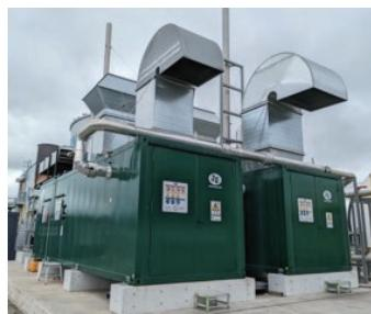
図8 バイオガスエンジン発電機
