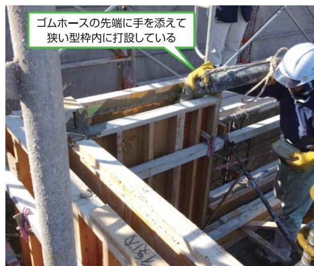
写真2 極低吐出打設一例
