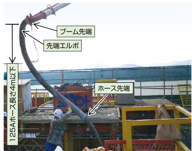
図16 吊打ち式(先端エルボ式)(韓国での事例)
