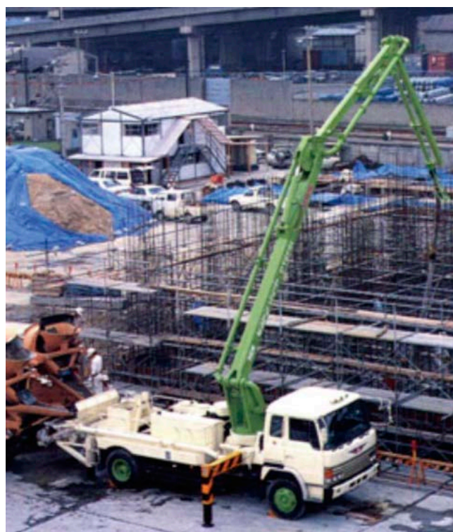
写真1 生コン打設工事
