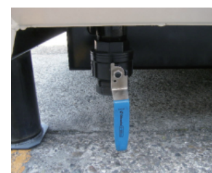
水抜きパイプ (コック付)
