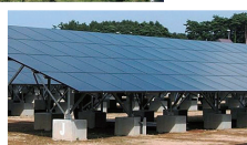
太陽光パネル▶
