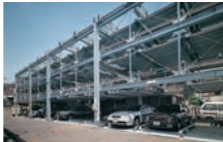
立体駐車装置
