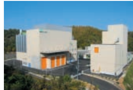
廃棄物ガス化溶融施設▲
