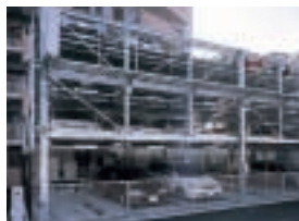
▲ 立体駐車装置
