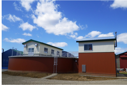
バイオガスプラント
