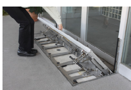
②防水板を下ろす。
