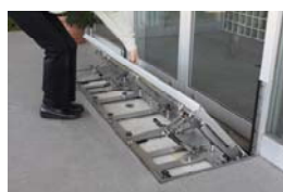
②防水板を下ろす。
