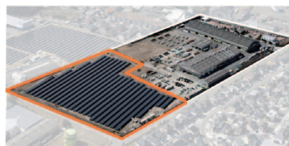
福岡工場メガソーラー発電所
