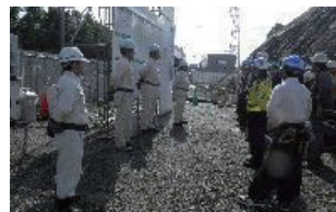
安全事項の伝達（環境事業部 建設現場）
