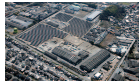
福岡工場 【敷地面積 43,503㎡】
