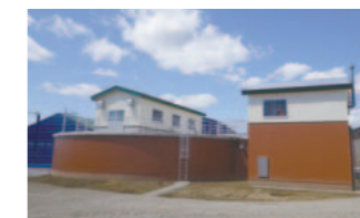
バイオガスプラント
